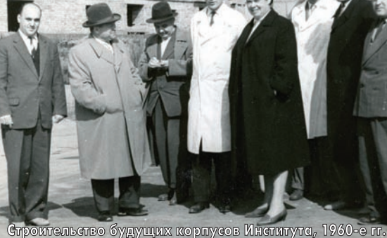
Строительство будущих корпусов Института, 1960-е гг.
